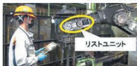
リストユニット部点検作業
