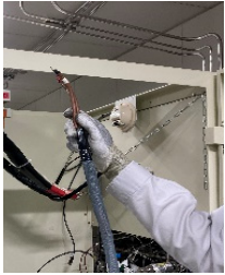
設備上部にてケーブル投入
